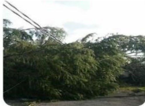
Gennaio 2018. Effetti del vento: caduta sostegni delle linee aeree e caduta piante (Sicilia)
