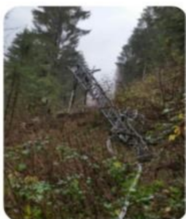
Ottobre/novembre 2018. Effetti del vento: caduta sostegni, rottura conduttori delle linee aeree, difficoltà logistiche (Lombardia)
