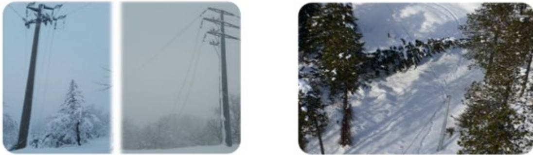
Febbraio 2018. Effetti delle nevicate: caduta sostegni, rottura conduttori delle linee aeree e caduta piante (Emilia-Romagna inizio di febbraio)
