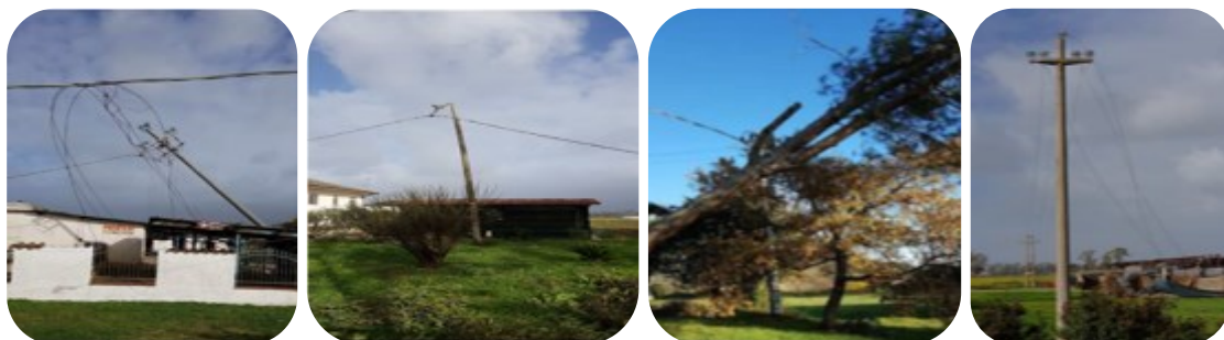
Dicembre 2019. Effetti del vento: caduta sostegni, rottura conduttori delle linee aeree e caduta piante (Lazio)
