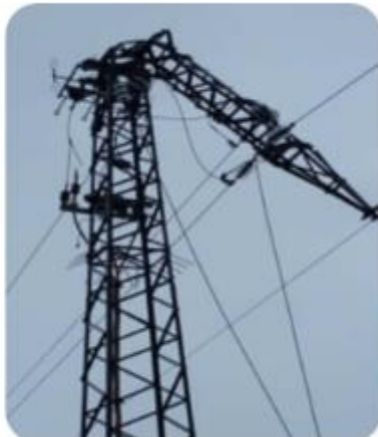
Ottobre/novembre 2018. Effetti del vento: caduta sostegni, rottura conduttori delle linee aeree, difficoltà logistiche (Lombardia)
