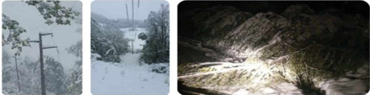
Maggio 2019. Effetti delle nevicate: caduta sostegni, rottura conduttori delle linee aeree e caduta piante (Emilia Romagna)
