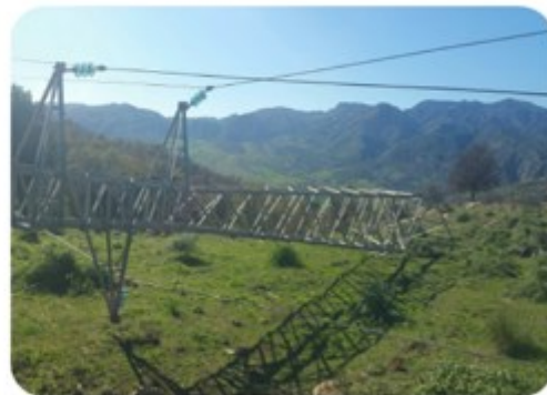
Gennaio 2018. Effetti del vento: caduta tralicci delle linee aeree e caduta piante (Calabria)
